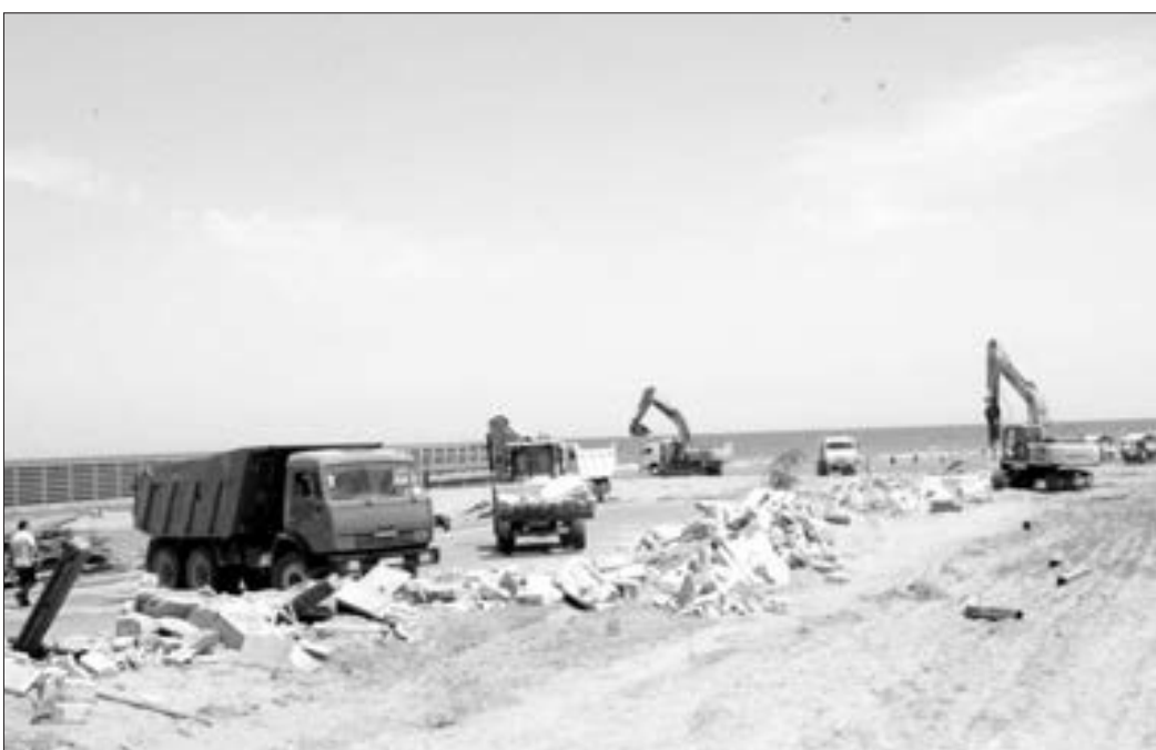
Buzovnada dəniz sahilindəki qanunsuz hasar və tikililər sökülür
